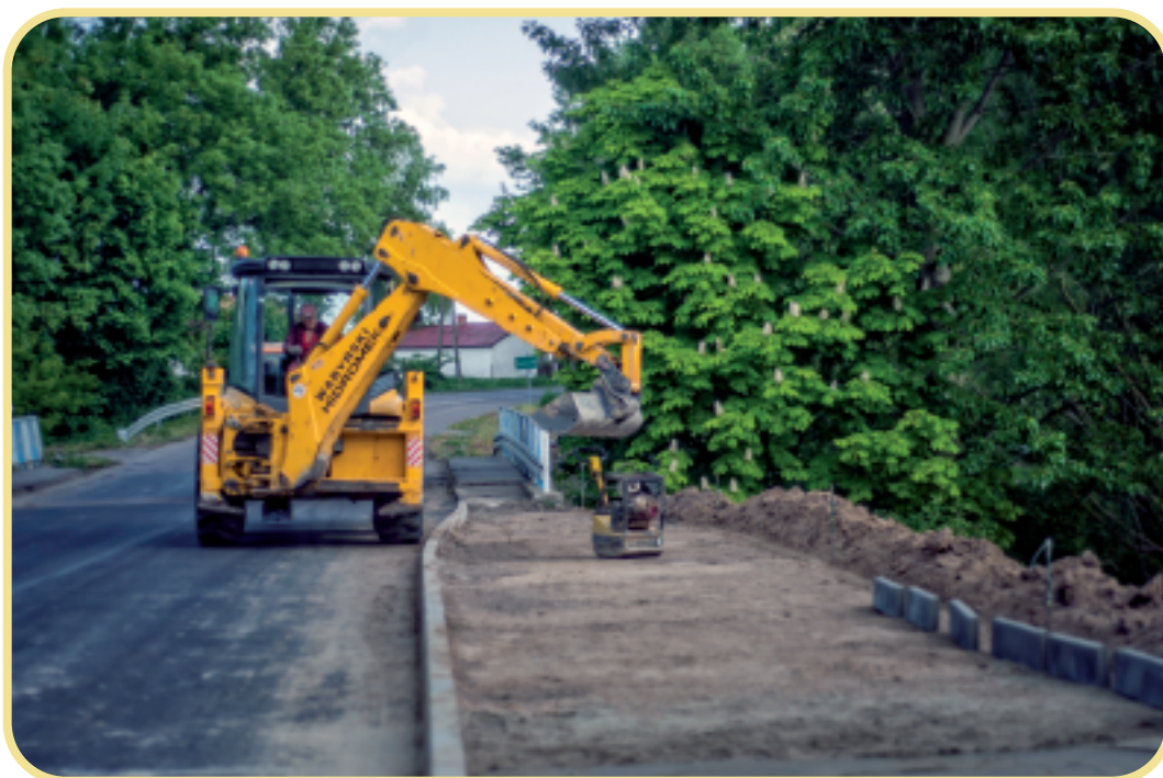
Projekt IPBU.01.03.00-06-318/11 - Poprawa dostępności i jakości przygranicznej infrastruktury drogowej Etap II - przebudowa II odcinka drogi powiatowej Nr 3432L Hrubieszów-Kryłów-Dołhobyczów-Granica Państwa oraz remont drogi w Uhrynowie
